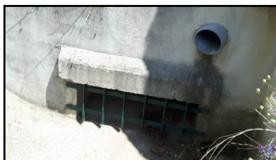
Vue du cadre sous la RD113
