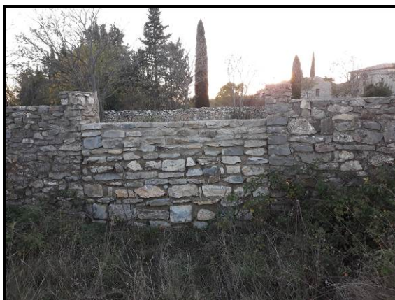
Vue de la partie reconstruite du mur en pierre
