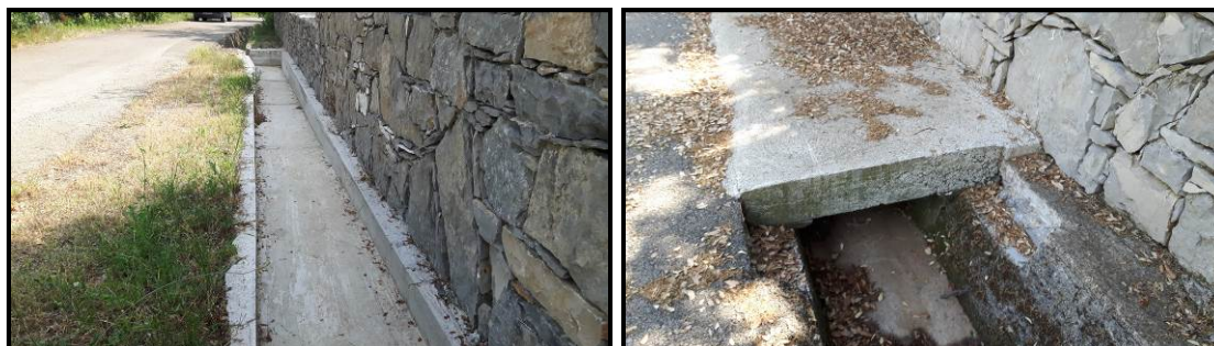
Vue d'un fossé et d'un ouvrage
