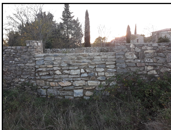
Vue du mur à réouvrir
