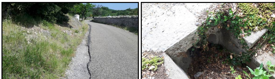
Vue d'un fossé et d'un ouvrage
