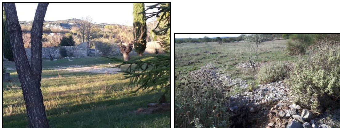
Vue des atterrissements des matériaux
