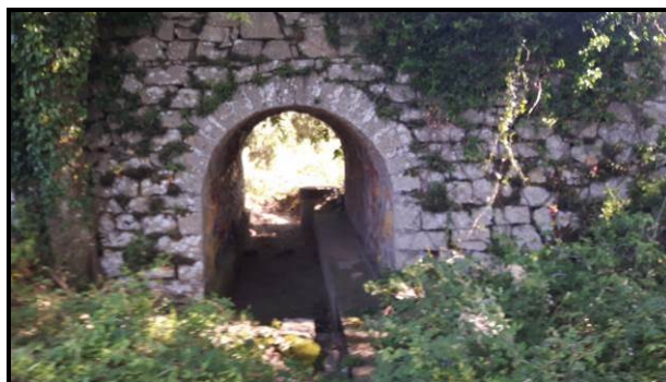
Vue de l'ouvrage Voûte
