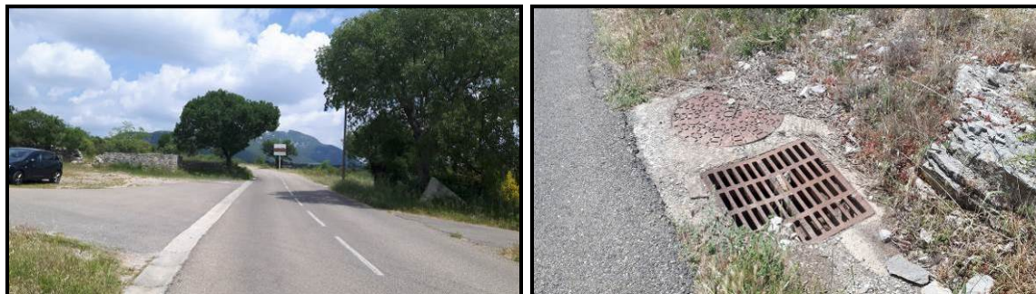
Vue de la cunette et du regard de la buse Ø300
