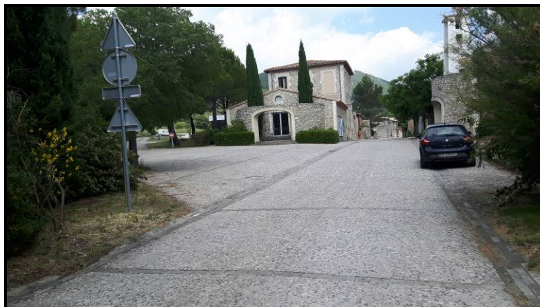
Vue du centre ancien de Cazevieille
